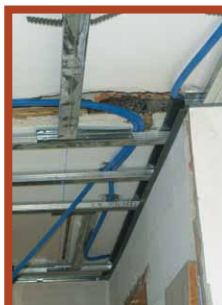
Unterdecken- konstruktion
